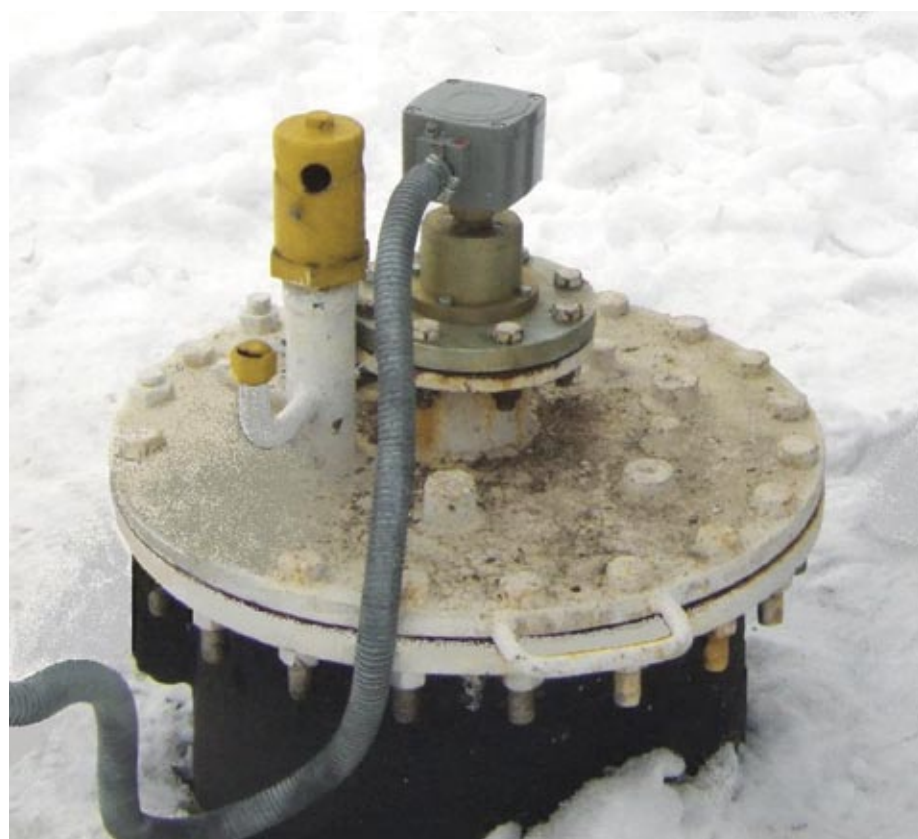
Рис.3 Монтаж прибора МПУ-100 на резервуаре со сжиженным газом
