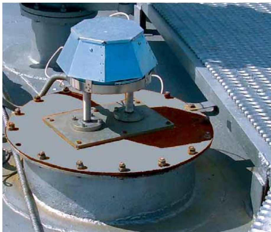
Рис. 2 Радиолокационный уровнемер БАРС352И с солнцезащитным козырьком
