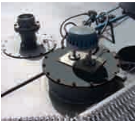
Рис.2 Монтаж двухантенного уровнемера на резервуаре РВС-1000.
